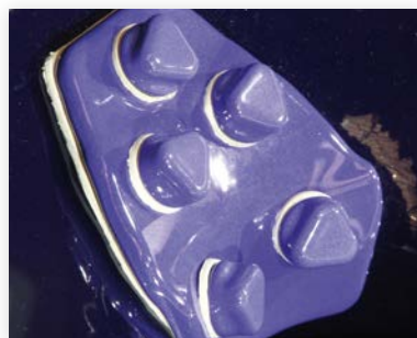
4: RepCap-Verschraubung zum Befestigen eines emaillierten EmPads / RepCap screw connection to attach a large sized glass-lined EmPad repair element
